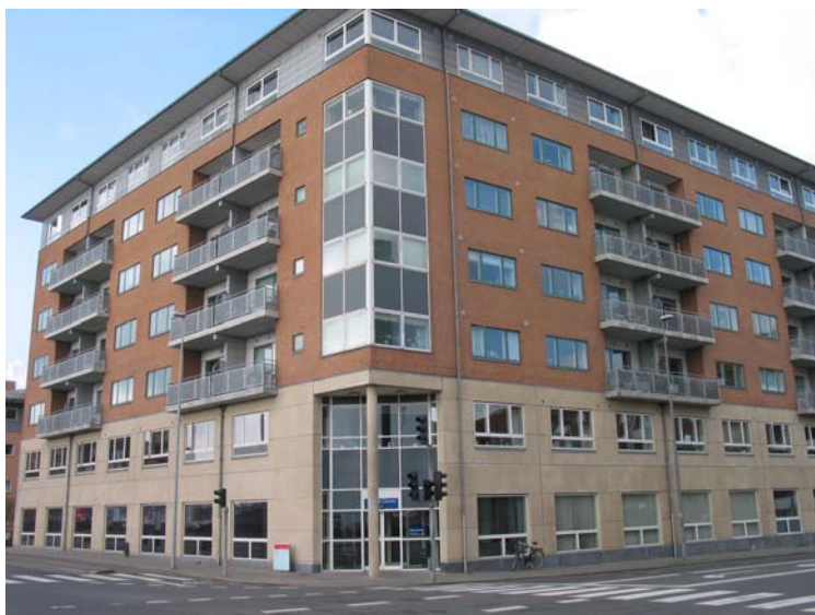
Åpark Centret – krydset Løvenørnsgade/Lichtenbergsgade
